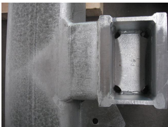
54. kép: Hőfoltosság (szürke elszíneződés) a túl lassú lehűlés következtében
