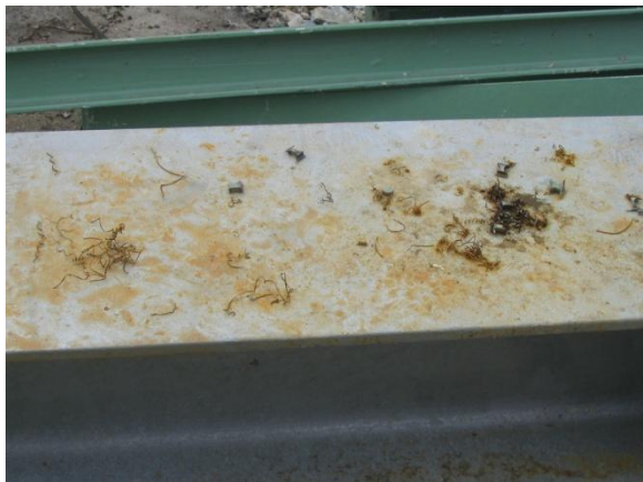
52. kép: Horganyzott felületre utólag rákerült fémforgács
