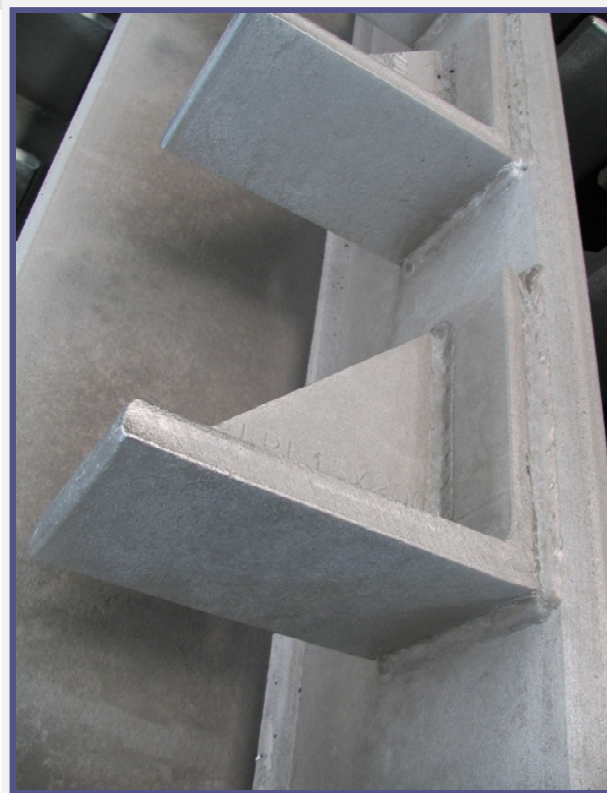
Az ilyen, vastagfalú, hegesztett acélszerkezetek eshetnek a DASt 022 irányelv hatálya alá
