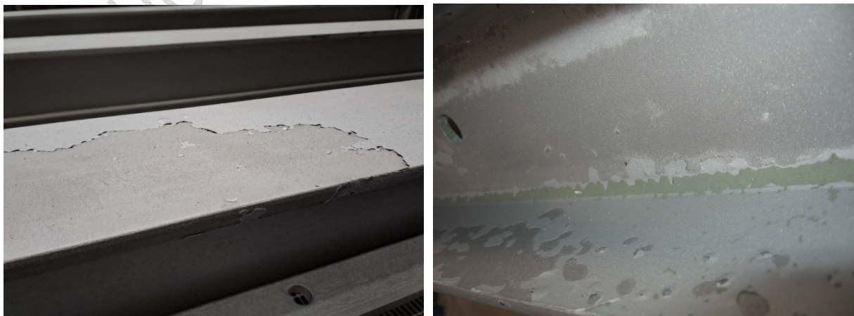
9-10. kép: Sweep-szórás közben az alsó bevonatrésről levált rétegek
