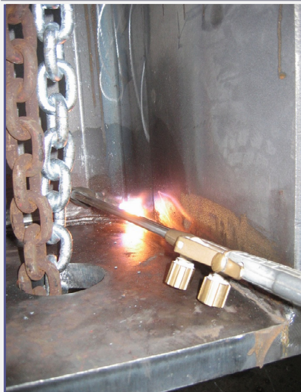
Lángvágással készített technológiai nyílás nem ajánlott megoldás
