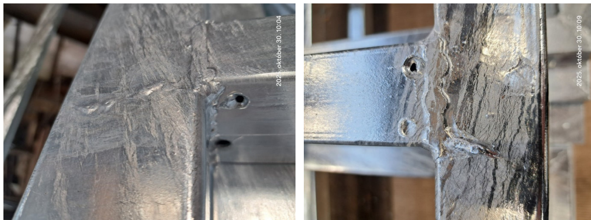
10-11. kép: Horgany „utánfolyások” a szerkezetek oldalán
