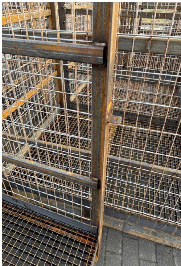
17-18. kép: Zártszelvények és L-acélok nyitott végekkel
