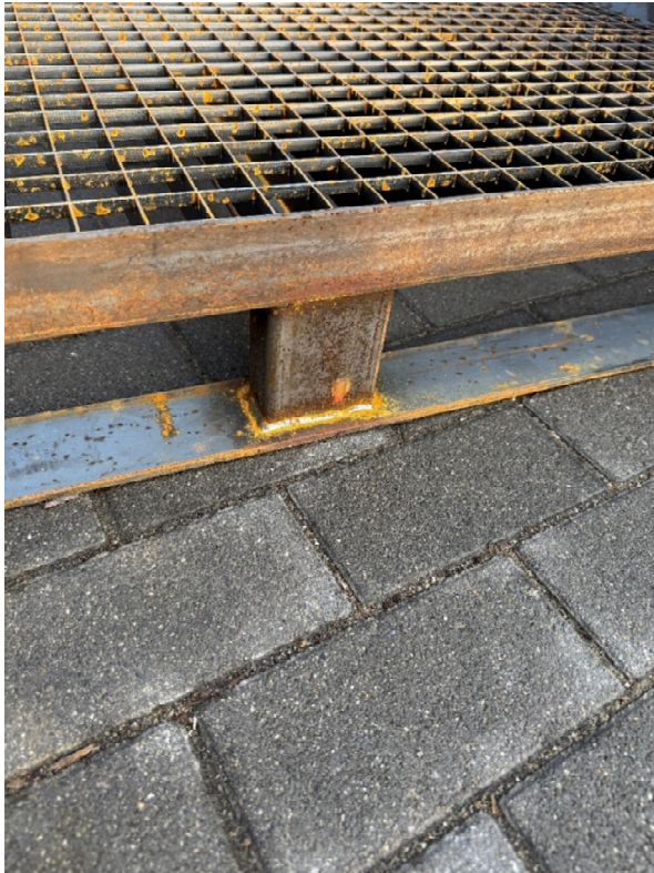
15. kép: Hiányoznak a technológiai nyílások
