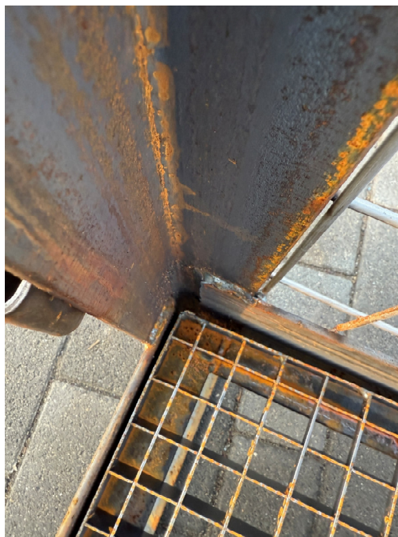
20. kép: Folyadékzsebek miatt nem horganyozható konstrukció
