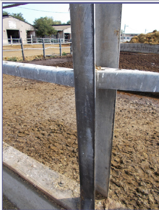
Tűzihorganyzott korlátszerkezet több évtized elteltével is kifogástalanul ellátja a feladatát
