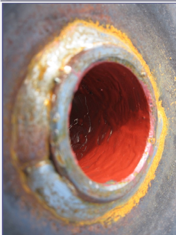
Illesztett felületek és menetek védelme fontos a gépjármű vázok tűzhorganyzása előtt
