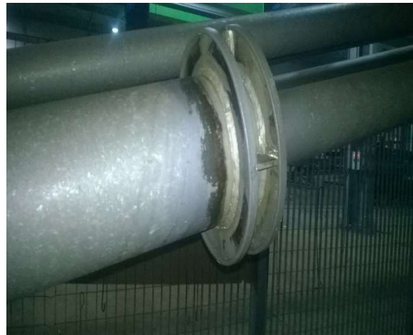
9-10. kép: Hegesztési feltapadásgátló spray nyomai a hőhatási övezetekben
