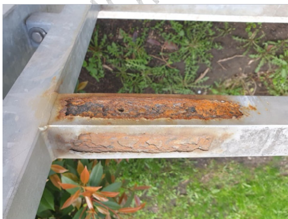
9. kép: A szelvény belsejéből kiindult rozsdásodás képe
