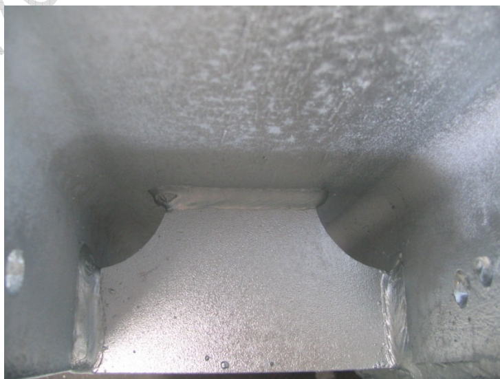
9-10. kép: Fényes, esztétikus horganybevonatok optimális méretű technológiai nyílásokkal
