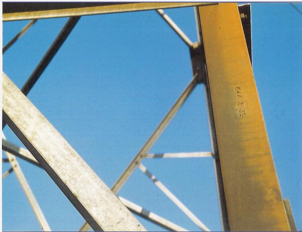
A barnás rétegek alatt legtöbbször még vastag horganybevonat van, ez a rozsdabarna elszíneződés
