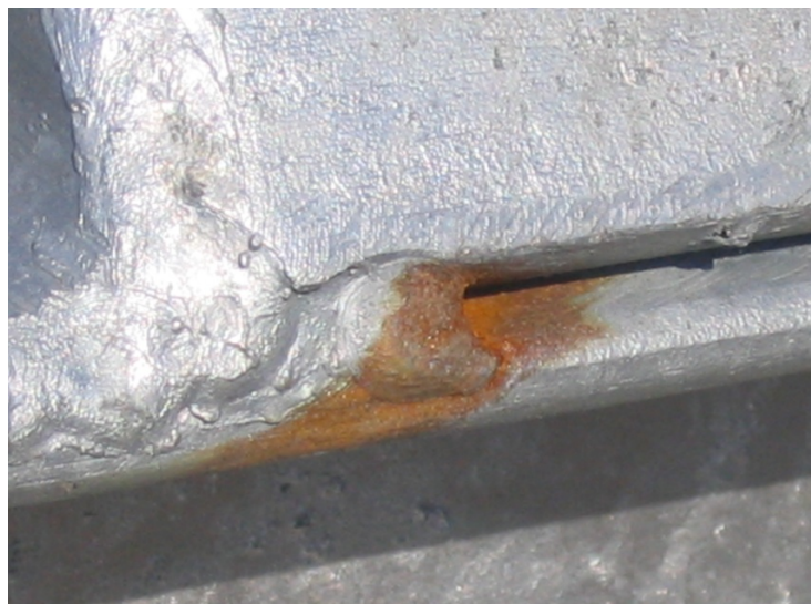
17-18. kép: Korrozív hatású, rozsdás lé kifolyások a le nem zárt felületek közül
