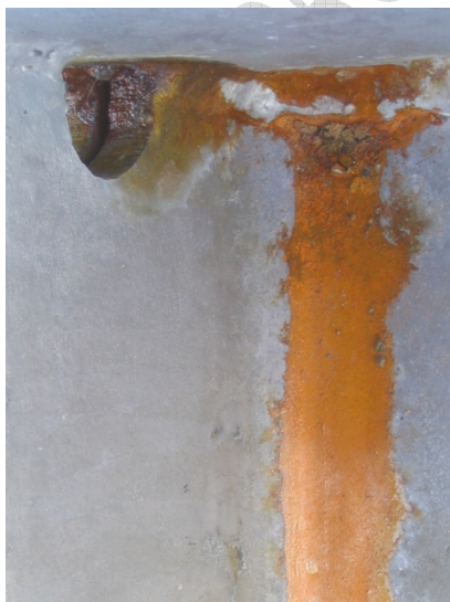
17-18. kép: Korrozív hatású, rozsdás lé kifolyások a le nem zárt felületek közül
