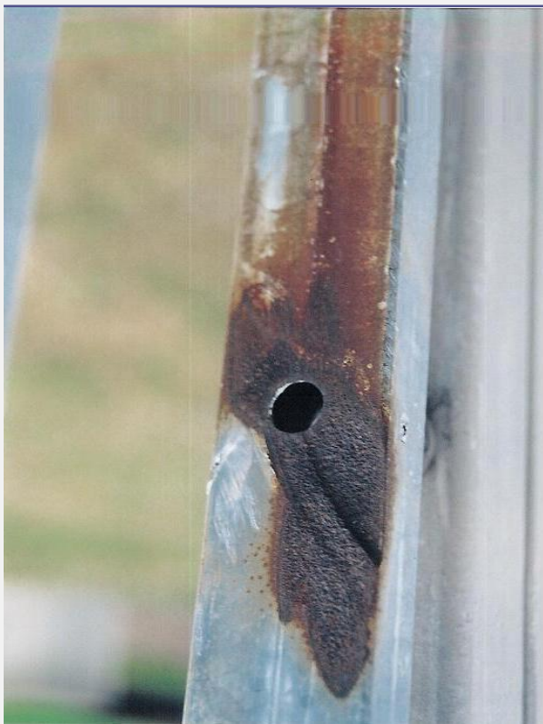
Sokéves „idegen” rozsa nagyon csúnya, korrodálódott felülettel (köszörülés, vagy vágás nyoma)
