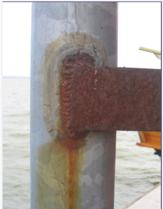
„Idegen” anyagtól keletkezett rozsa igen feltűnő jelenség, el kell kerülni
