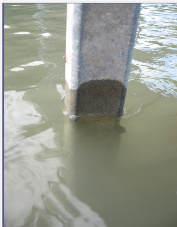
Korróziós hatásoknál mindig kritikus terület a vízzel esetenként érintkező felületrész
