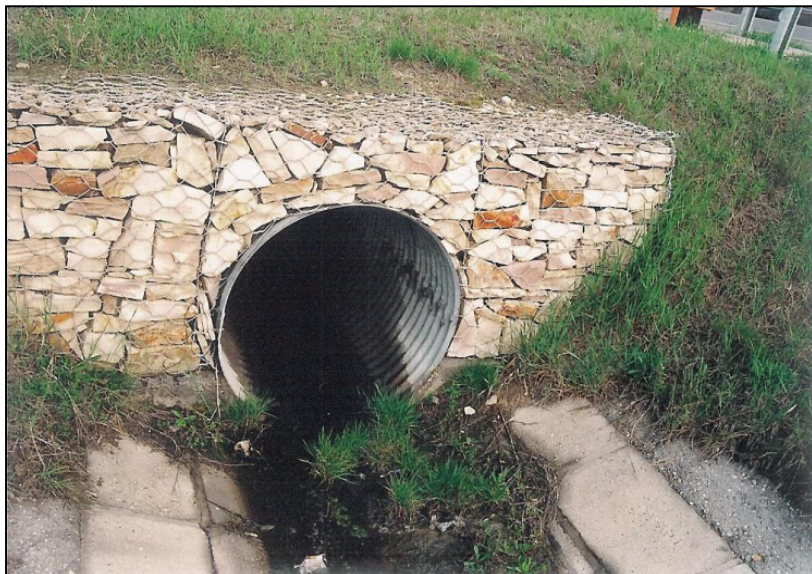
3. kép: Tűzihorganyzott kivitelű átereszt
