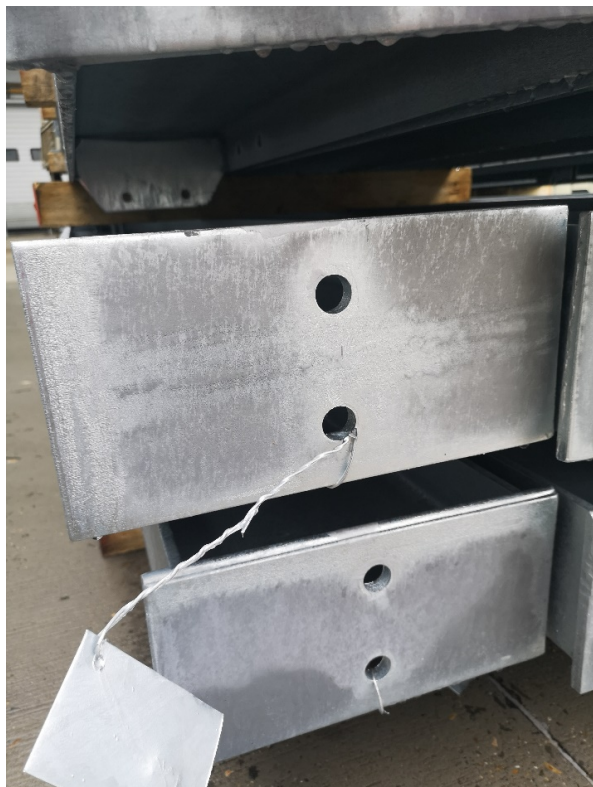
18. kép: Az időjárásnak kitett felületeknél a hőfoltok is jobban meglátszanak
