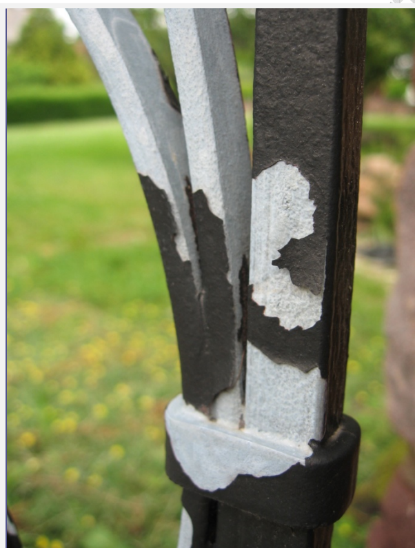
Helytelen technológiával végzett festés miatt a horganybevonatról leváló műanyagréteg
