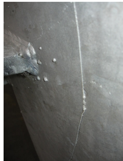
21. kép: Repedés egy horganyzott acélszerkezeten
