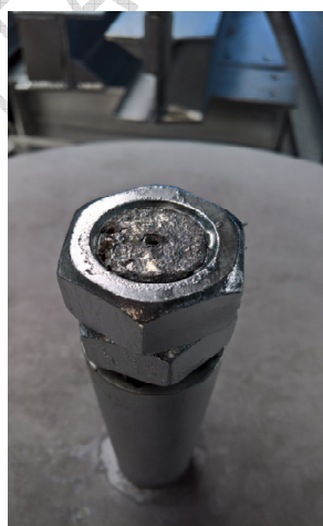
1-3. kép: Szilikon hüvelyek és menetvédő anyák
