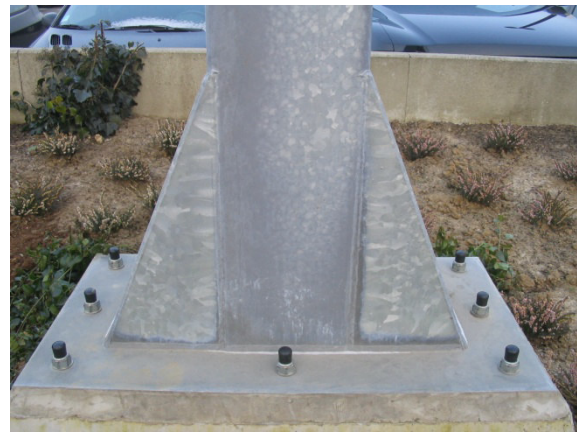
3-4.kép: Enyhébben és erősen „rajzoltos” bevonatok közvetlenül horganyzás után és tíz év elteltével
