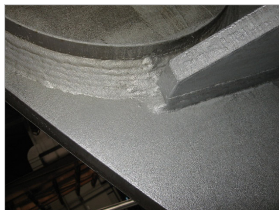
14. kép: Horganyréteg szemcseszórással előkezelt
