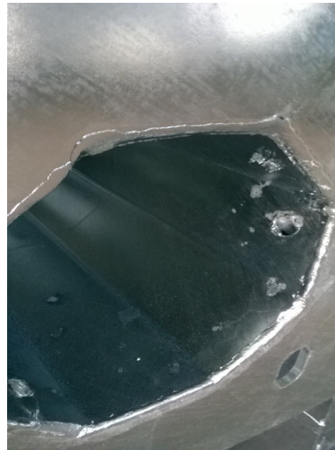
11. kép: Technológiai nyílás elhelyezése az oszloptörzsön a lapolás alatt
