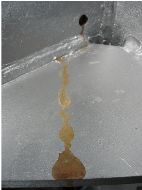
10. kép: Rozsdás lé folyik ki az átlapolt felületek közül
