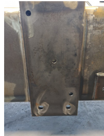
13. kép: Vastag anyagból készült átlapoláson nagy átmérőjű furatok szükségesek
