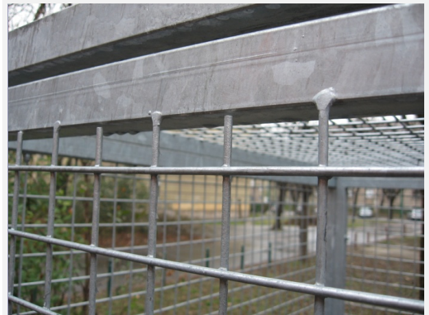
Amennyiben csak minden második köracél pálcát hegesztik le, kissé kedvezőbb lesz a megoldás.
