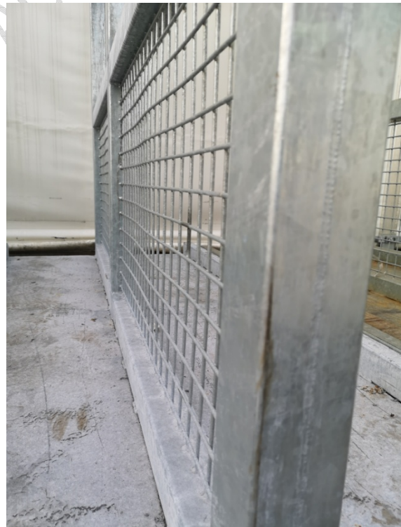
3. kép: Keretelembe hegesztett háló
