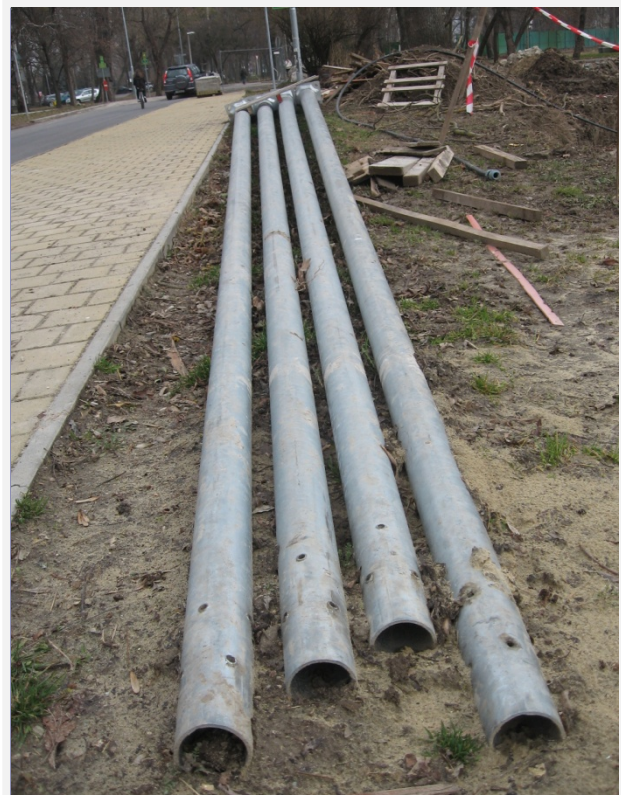
Földön, nedves talajon helytelenül tárolt tűzihorganyzott acélszerkezet a védőréteg károsodásához vezet.
