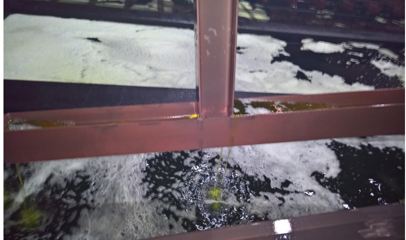
5. kép: Kisméretű nyílások gátolják a gyors folyadékáramlást
