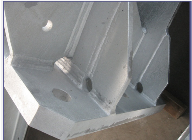
Talplemezeknél is biztosítani kell a szerkezet hossz-, és keresztirányú átöblíthetőségét.
