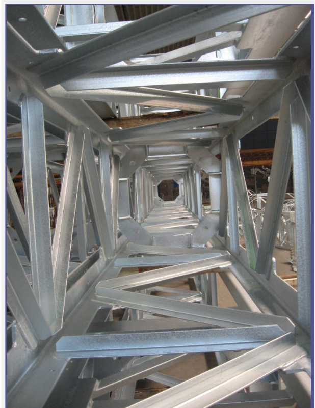
Különleges jelentősége van a szögacélokából gyártott acélszerkezetek helyes lesarkolásainak.
