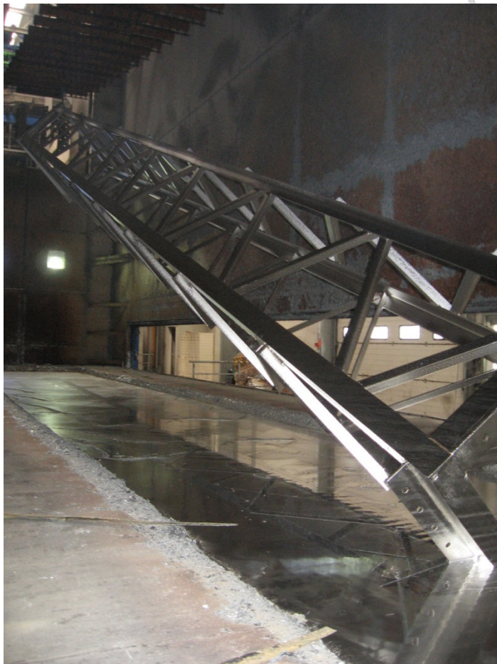
1. kép: Rácsos acélszerkezet kiemelés közben
