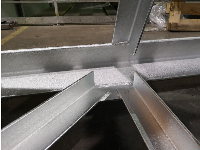
8. kép: Csatlakozási pontok kialakítása a már horganyzott szerkezeten
