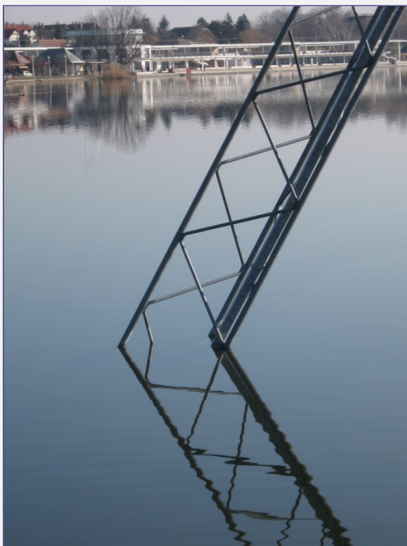
Egy 100 µm vastag tűzihorgany bevonat víz alatt is már több évtizedes védelmet biztosít az acélnak.
