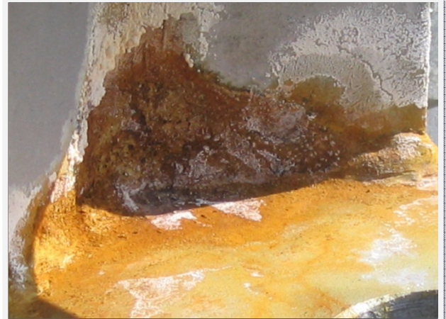
Súlyos korrózió, fehérrozsás felület. A jelenség már bevonat lepusztulását okozta.
