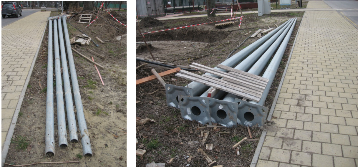
7-8. kép: Hanyag, szakszerűtlen tárolás az építési területen
