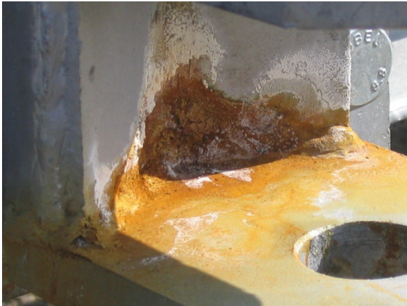
3. kép: Súlyos fehérrozsda
