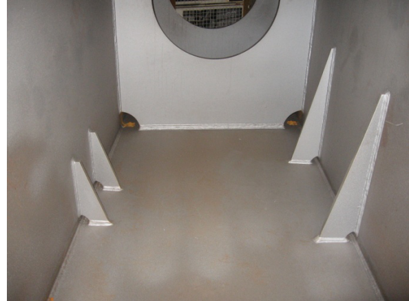
12. kép: Megfelelő sarokkivágás
