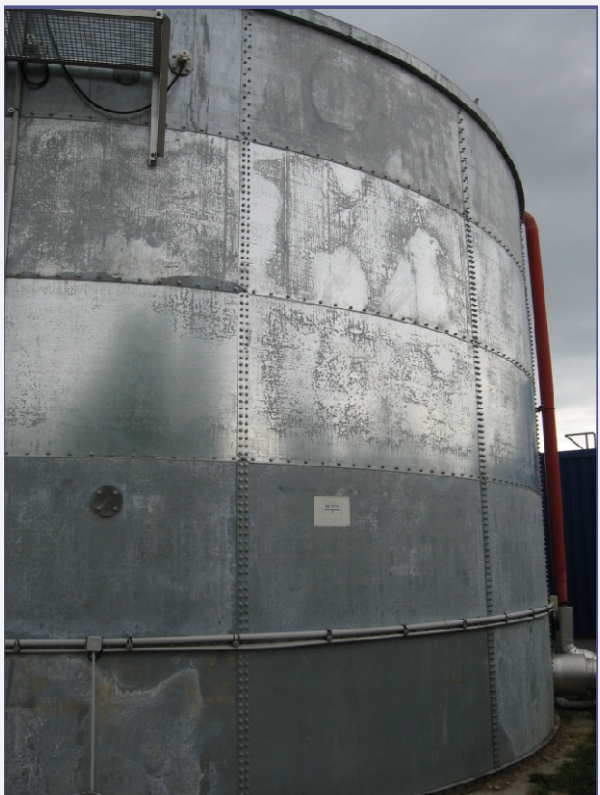
A látványosan korrodálódott tűzihorganyzott lemezfelület nemkívánatos jelenség.
