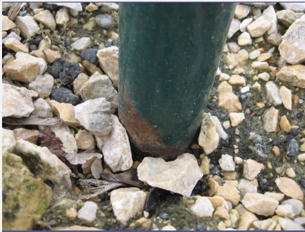
Szinterezett acélszerkezet korróziója 10 év elteltével komoly károsodást mutat.
