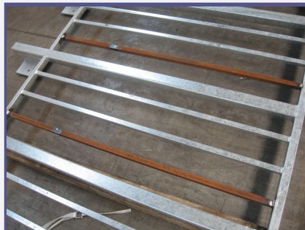
Utólagosan behegesztett elemek alkalmazása nem előnyös, újrahorganyzás szükséges.
