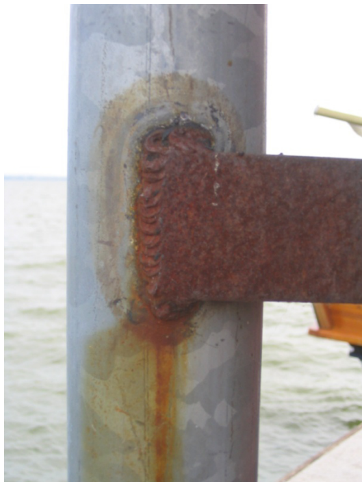
1. kép: Utólagos hegesztés következménye
