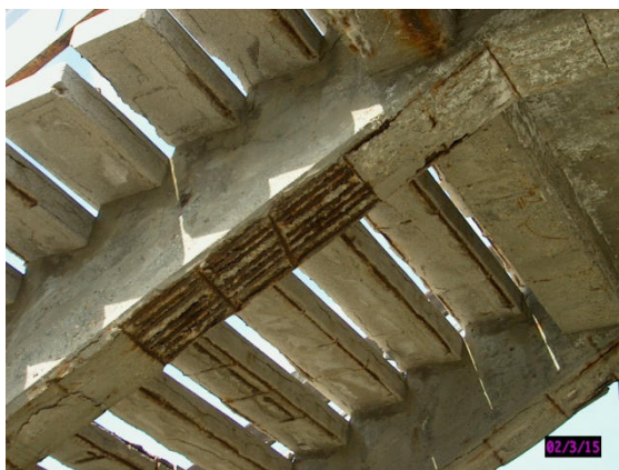
1-2. kép: Acélbetétek korróziós tönkremenetele
