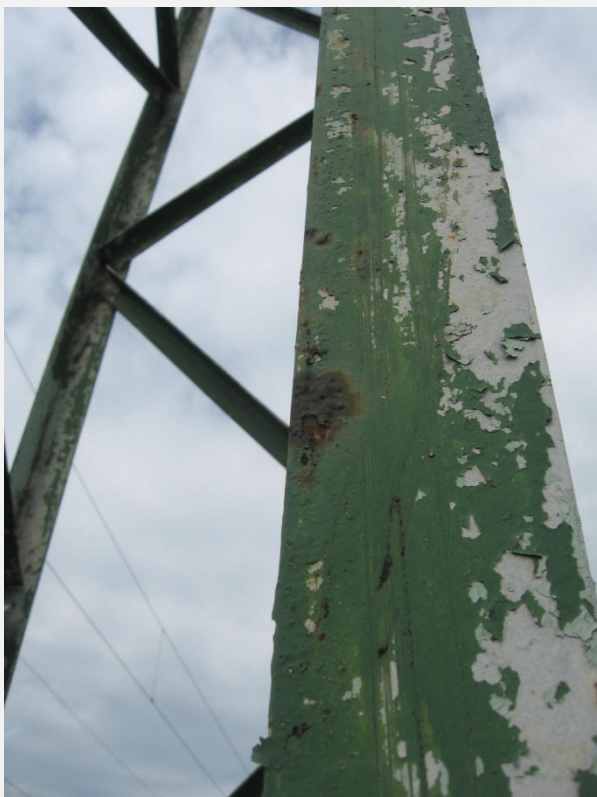
Korrodálódott, festett felületek ciklikusan felújításra szorulnak.
