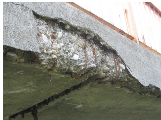
1-2. kép: Acélbetétek korróziós tönkremenetele
