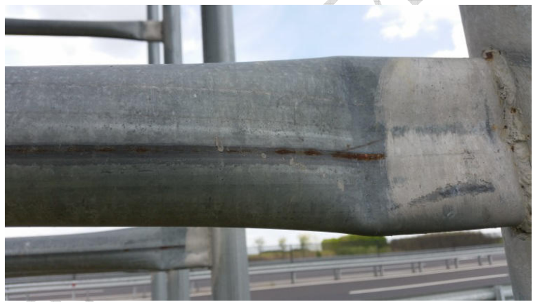
7. kép: Vékonybevonatos cső hegesztésének korróziója táblatartó szerkezetnél
