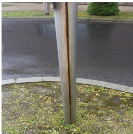
6. kép: Táblatartó cső erősen korrodálódó hosszvarrattal
