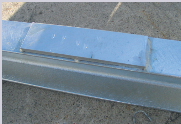
Az átlapolás és szakaszos hegesztés idővel korróziós göcot okozhat
