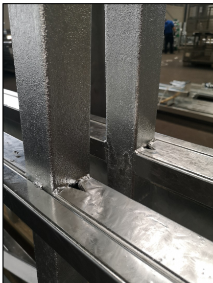
5. kép: Nem megfelelő acél alapanyag érdes bevonata
