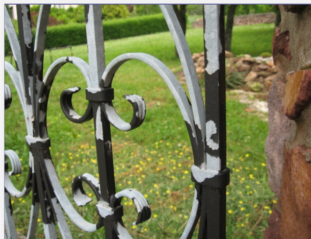
Helytelen technológiával festett kovácsoltvas kerítés
