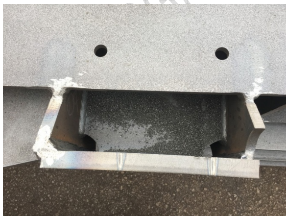
13. kép: Sörétmaradványok a szerkezetben
