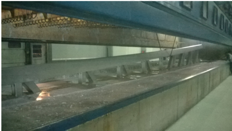
13. kép: Horganyfürdőbe lassan elmerülő hosszú acélszerkezet megnyúlása
