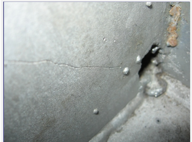
Helytelenül kivágott technológiai nyílásoknál nagyobb a kockázat a repedés kialakulására
