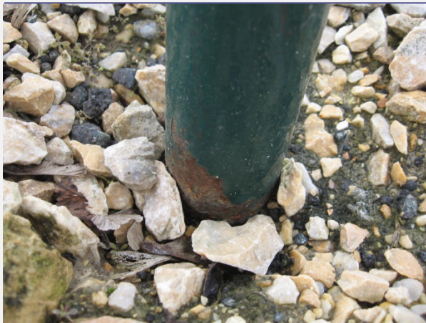
Festett acélcső korróziója sokkal erősebb a talaj közelében. 7-8 év elteltével levált a festékréteg.
