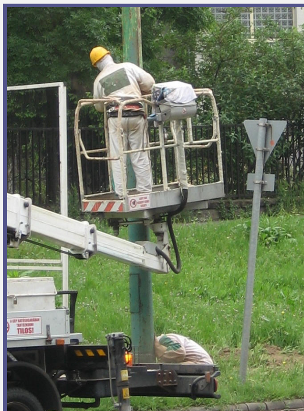
Korrodálódott, festett felületek gondos megújítása mindig jelentős fenntartási költségekkel jár.
