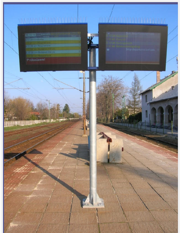
Külsőre főleg helyes döntés a darabaru tűzihorganyzás. Több évtizedes (>40-50 év), karbantartásmentes védelem.
