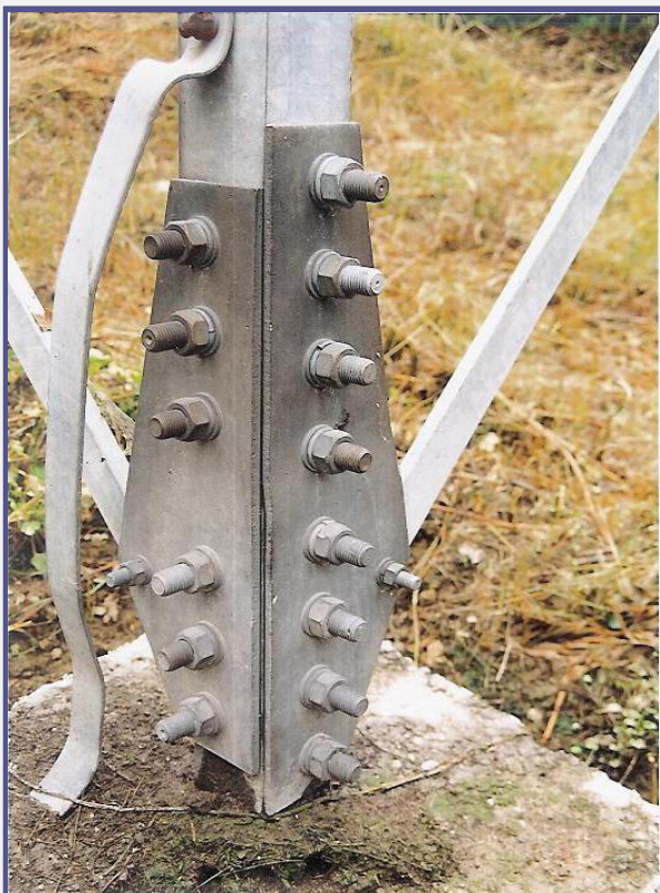
Oszlop alsórész tűzihorganyzott csavarokkal. Legkisebb megengedett bevonatvastagságuk 50 µm.
