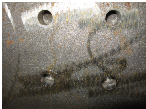
5.--6. kép: Átlapolt felületek helyes kialakításai a gyakorlatban (balra, 70 \text{ cm}^2 alatti felület körbe hegesztve, jobbra, fúrás átlósan az alaplemezig)
