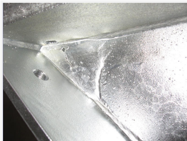
Rossz konstrukció, hiányzó technológiai nyílás.
