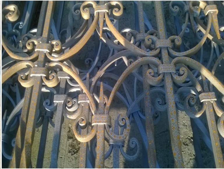
4. ábra: A rögzítő pántokat (átlapolásokat) hézagokkal helyezzük el
