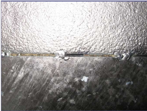
Erősen korrodálódott (vakrozsdás) felület tűzihorganyzást követően (felül).
