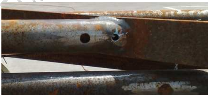
12. ábra: Új furatot kellett fúrni (jobb oldali lyukat)
