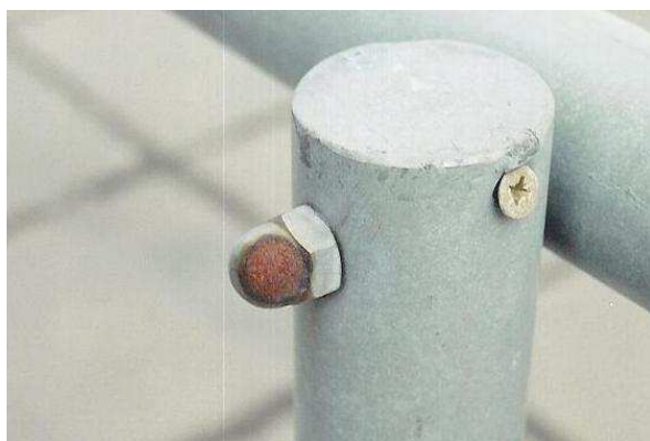
2. ábra: Lekopott a galvanikusan horganyzott csavarról a védőréteg
