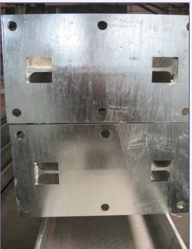
Gerinclemez tartók ötletes megoldása a technológiai nyílások kialakításához.
