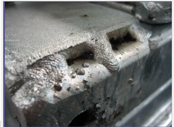
A szakaszos hegesztési varratok (rálapolásnál) korróziós göccokat is jelentenek.
