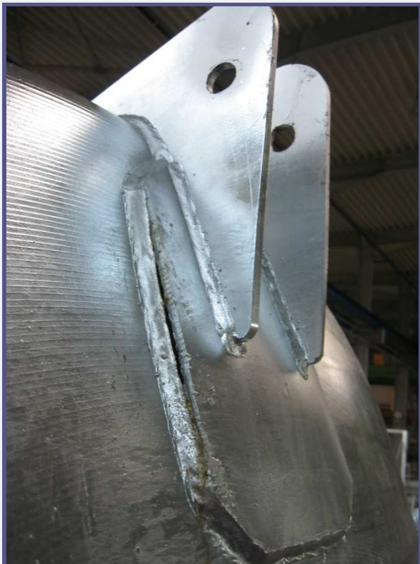
A nem megfelelő hegesztés miatt, a rálapolt felület alá jutott nedvesség gőzzé válva szétfeszítette a felületet.
