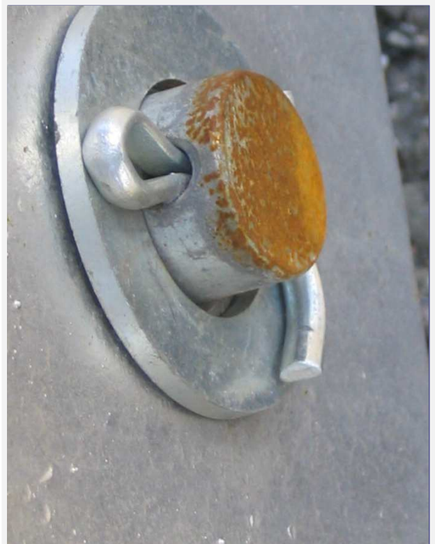
Tűzihorganyzott acélszerkezeten galvanikusan horganyzott tartócsap korróziója 1-2 év elteltével.
