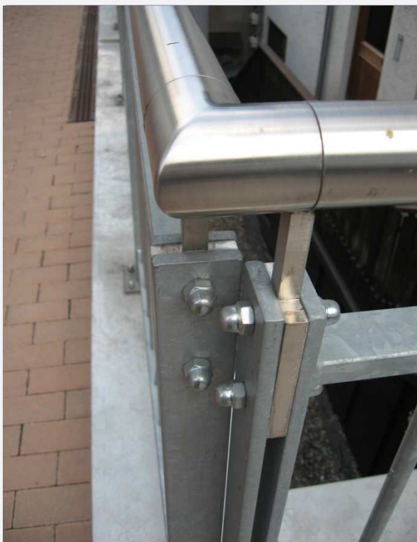
Tűzihorganyzott korlátszerkezet és korrózióálló acélból készített korlát csavarokkal. A bekötő lemezek és horganyréteg közé szigetelést javasolunk tenni.
