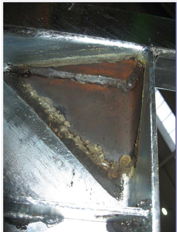
Légszákos szerkezettrész hiányzó technológiai nyílás miatt
