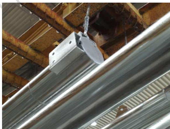
7. ábra: Kilevegőző és salakkíáramló nyílás oldalt, de kell a legfelső ponton is
