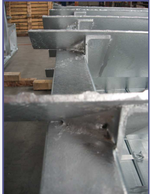
Hiányzó technológiai nyílások miatt horgany maradt a szerkezet sarkaiban
