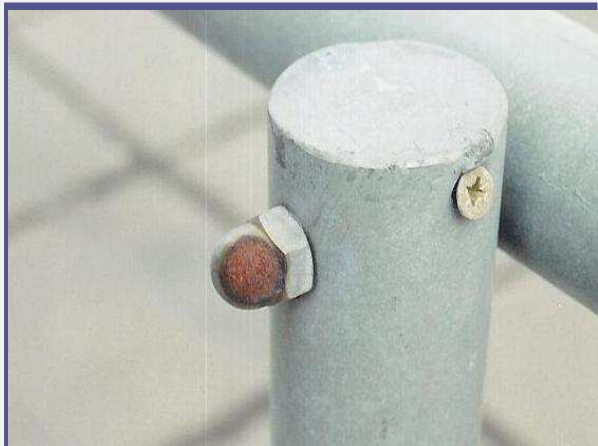
Galvanizált csavar egy év múltán kültéri körülmények között
