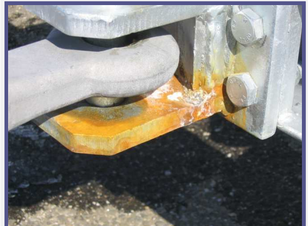
A galvanizált kapcsolódóm felületén túl vékony volt a horganyréteg
