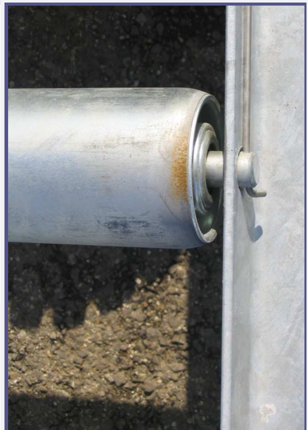
Galvanikusan horganyzott görgő és tűzhorganyzott acélszerkezet összeépítve
